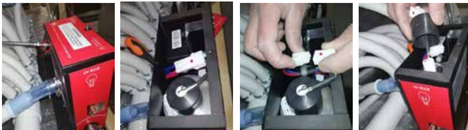
1. Schritt: Lösen Sie die 2 rot markierten Schrauben. 2. Schritt: Die rote Abdeckung abnehmen 3. Schritt: Weiße Verbindungsstücke entkuppeln 4. Schritt: Schwarze Abdeckung herausnehmen
