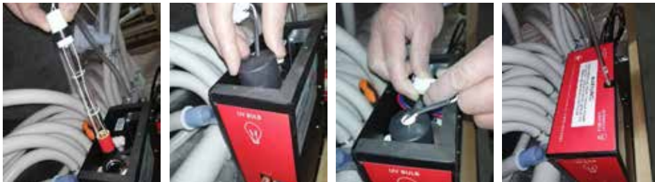
5. Schritt: UV Licht zum Wechseln rausnehmen 6. Schritt: Neues UV Licht in die Metallröhre stecken und schwarze Abdeckung wieder darauf stecken 7. Schritt: Weiße Verbindungsstücke wieder verkuppeln 8. Schritt: Rote Abdeckung wieder festschrauben
